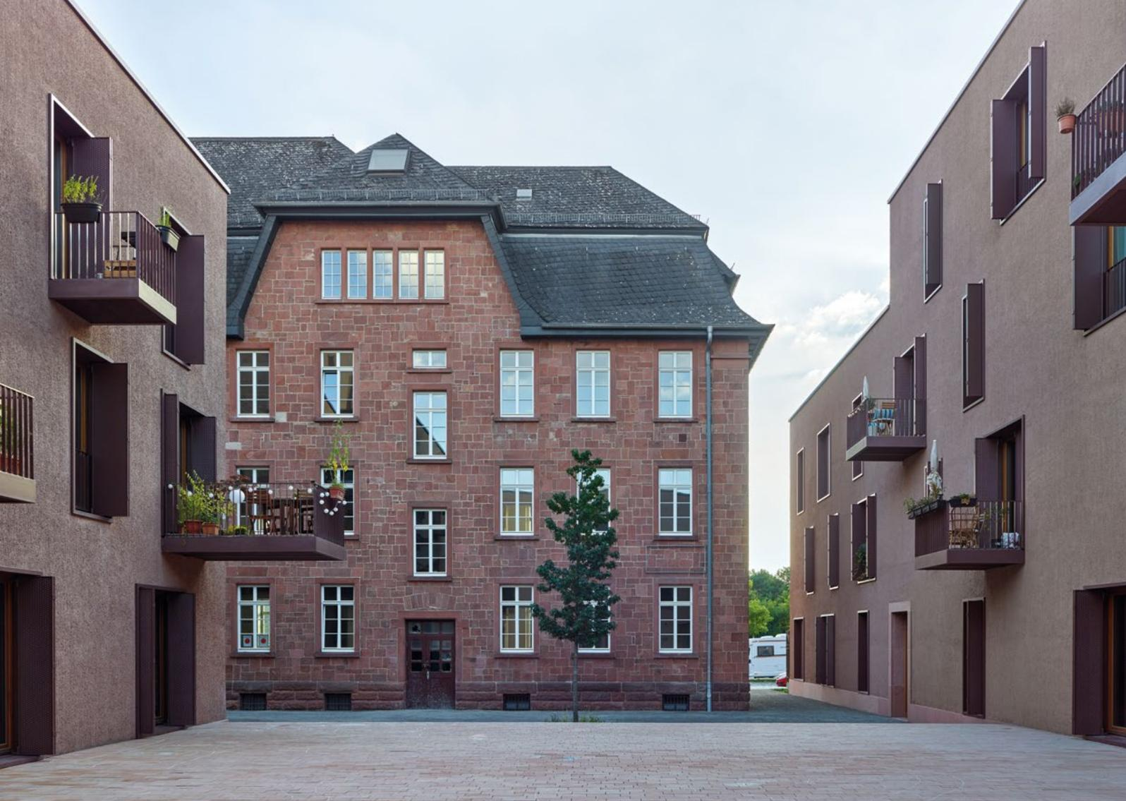
↑ Un crépi léger minéral brun clair et les châssis en acier des ouvertures des fenêtres et balcons créent une connexion avec la fin du XIXe siècle et le bâtiment existant.
