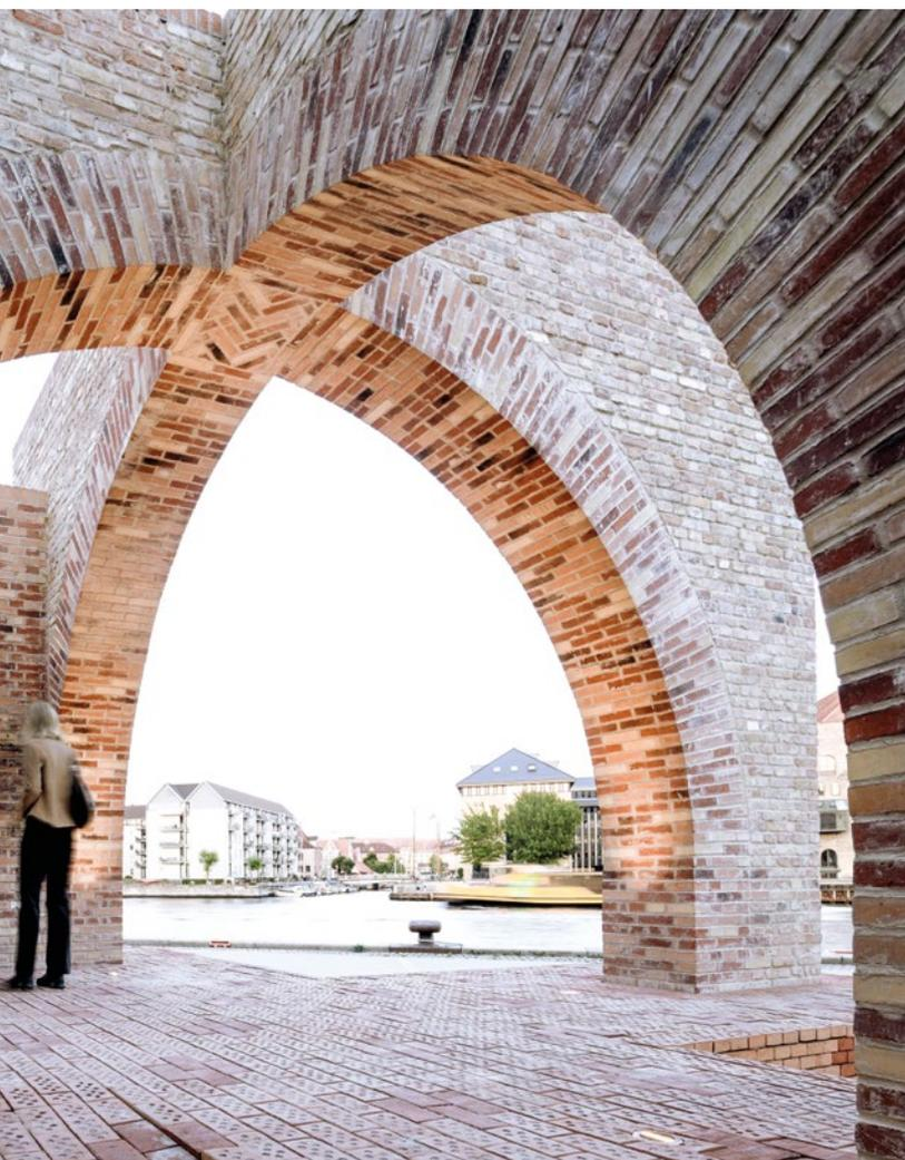
← La plus grande voûte se compose de la série de briques de façade LESS réduisant les émissions de CO<sub>2</sub> d'Egersund, cuites au gaz bio. 70 % sont des briques recyclées.
