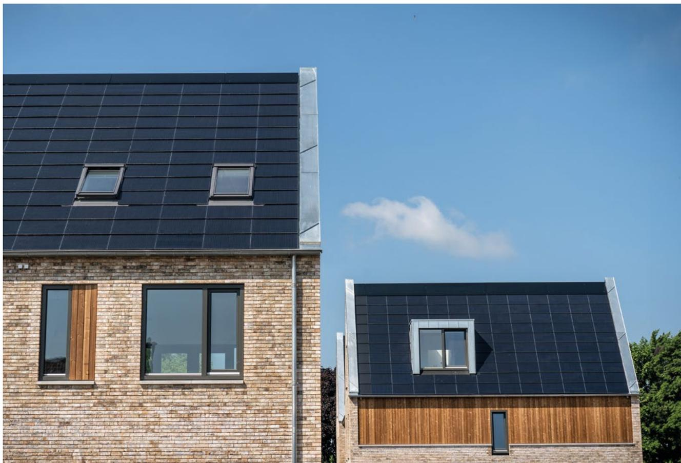
↑ La façade en ClickBrick Pure a l'aspect d'une maçonnerie traditionnelle avec jointure classique, mais se compose de briques de façade posées à sec. Cela permet une pose rapide et propre, tout en facilitant d'éventuelles réparations.
