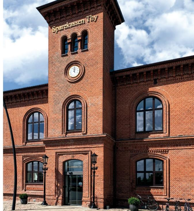
Des briques circulaires, carrées, orientées dans un autre sens, ainsi que des briques d'angle et de bordure arrondies figurent parmi les plus de 500 briques fabriquées sur mesure pour Toldboden à Thisted. Le bâtiment accueille aujourd'hui la banque Sparekassen Thy.
