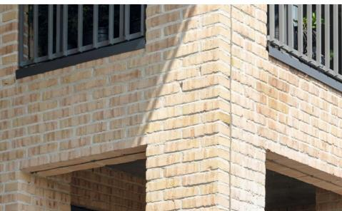
Face arrière orientée vers l'extérieur : les architectes ont utilisé le relief rugueux de la face arrière de la brique de parement à certains endroits du bâtiment afin de créer une façade vivante.
