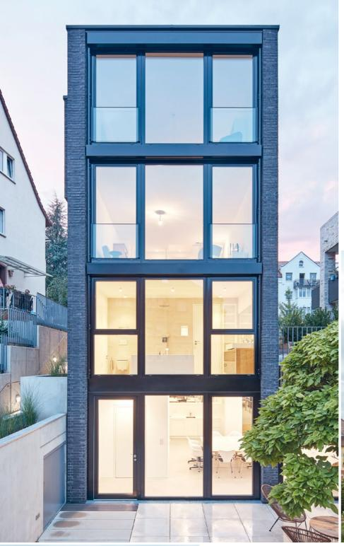
Gauche : Grâce à ses murs extérieurs à double paroi avec une façade en Eco-brick $^{\oplus}$ , la maison urbaine répond au standard d'efficacité énergétique KfW-55.
