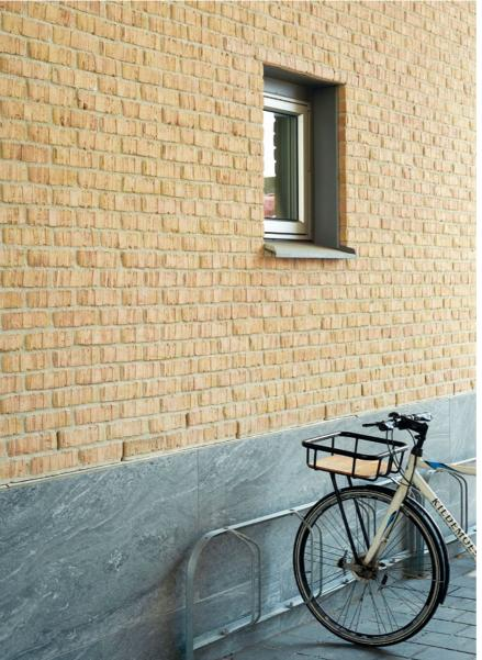
donnant vie. « La face arrière de la brique est bien plus rugueuse et peut ainsi servir à créer des détails intéressants. C'est une bonne option, par ailleurs peu coûteuse, pour dynamiser la façade. Le résultat est élégant et unique, et on conserve les avantages de la brique de parement », explique Filip Davidsson, directeur des ventes chez Wienerberger.
