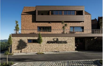
En haut : Une impression de bardeaux de mélèze : les tuiles en terre cuite vintage couleur sable engobes ont été posées sur le toit et la façade.
