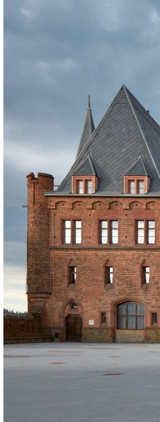
La première phase de reconstruction et de rénovation du monument incluait des modifications des murs, des voûtes, de la vigie et des charpentes du toit.
