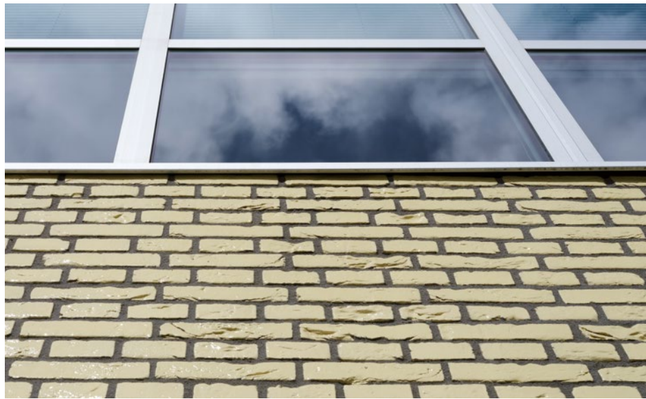
À l'origine, des briques rouges simples ont été utilisées, recouvertes ultérieurement d'un émail jaune pâle. Les nouvelles briques sont intrinsèquement jaunes, mais affichent la même texture et la même couleur émaillée qu'à l'époque.
