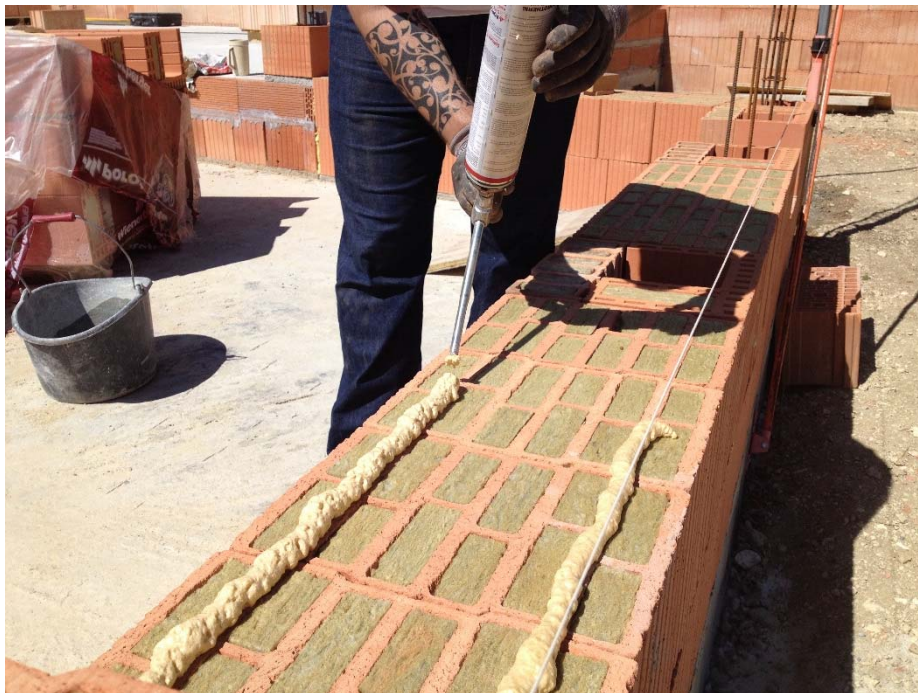
Figure 5– Application du Dryfix sur CLIMAmur 36
