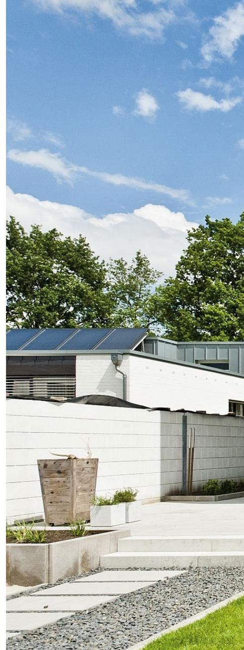
**UNE MAISON PASSIVE ÉCONOMIQUE** La maison pluri-générationnelle a été réalisée avec une structure à double peau à fort pouvoir d'isolation thermique, sous la forme d'une maison passive. Pour les murs extérieurs, des blocs d'argile d'une épaisseur de 17,5 centimètres ont été utilisés. Les murs intérieurs avaient besoin d'une isolation phonique efficace, également obtenue grâce aux blocs d'argile. Les enfants peuvent ainsi jouer sans déranger leurs grands-parents.
