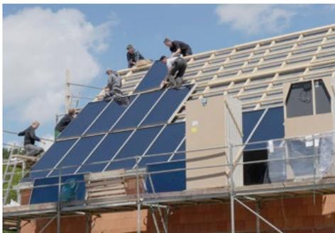
Montage des modules d'énergie solaire thermique et photovoltaïque sur le pan Sud de la toiture : le système solaire intégré à la couverture permet de combiner énergie solaire thermique, photovoltaïque et fenêtres de toit.
