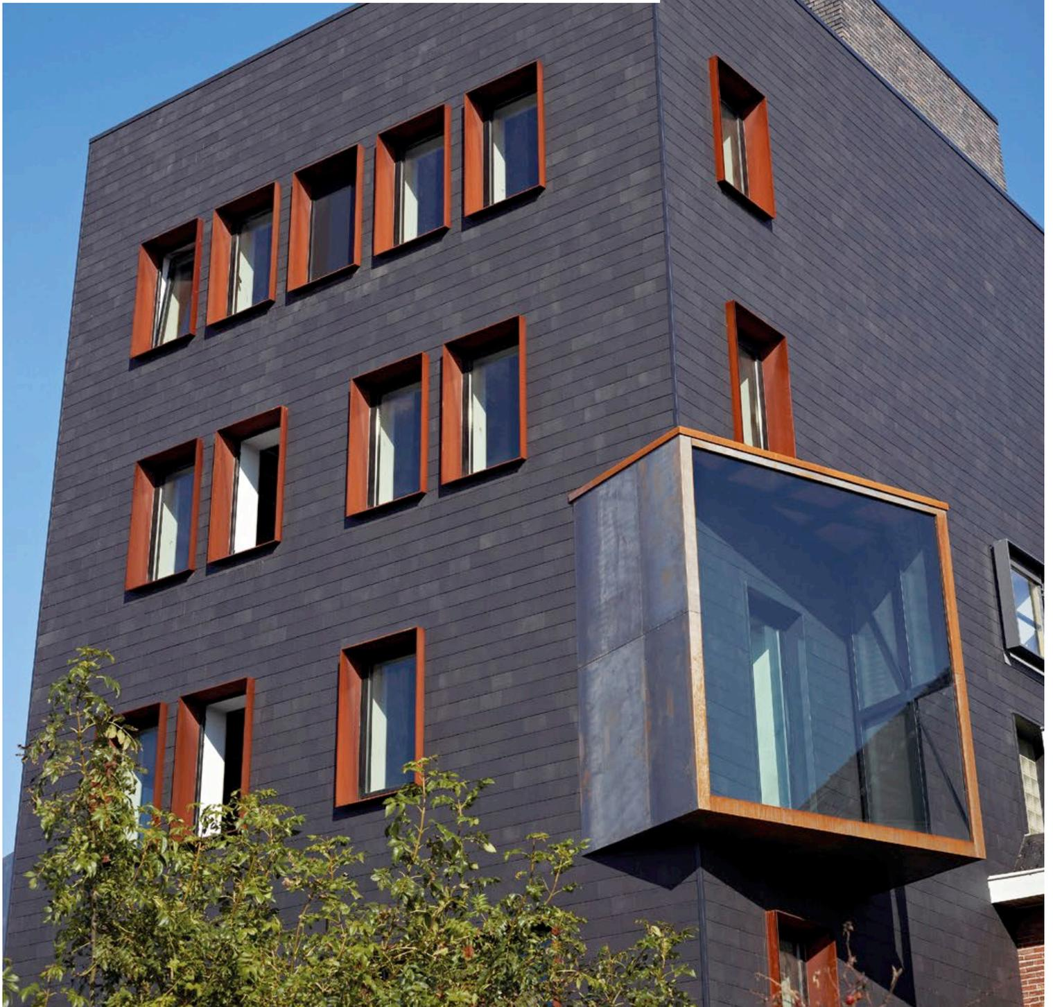
Les cinq étages de la tour ont été mis à nu jusqu'aux murs intérieurs avant de recevoir une isolation intégrale en polyuréthane et une construction porteuse en bois. La disposition des fenêtres situées dans les ouvertures existantes, variable d'un niveau à l'autre, a été conservée, et en phase finale l'ouvrage a été complété de deux cubes superposés dotés de vitrages émaillés.
