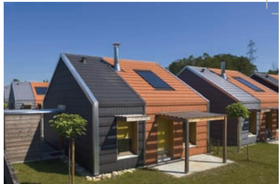
ventilation hygro-réglable bénéficie de l'effet de cheminée des façades ventilées et des combles comme volume-tampon pour apporter en toute saison le confort climatique. Des modules de capteurs solaires posés avant les tuiles sont encastrés dans la toiture, versant Sud. Ils assurent l'alimentation en eau chaude, avec un ballon de 200 litres en complément.
