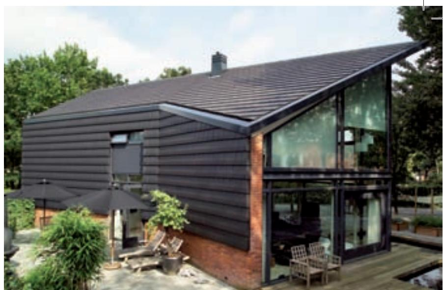
le toit et la façade. Une gouttière en aluminium dissimulée a été posée à cet endroit. Le revêtement de l'aluminium se pare d'une teinte identique à celle des tuiles. De plus, les chéneaux sont habilement masqués. L'ensemble est donc équilibré avec quelques formes principales et sans détails tarabiscotés. C'est précisément cette austérité qui le distingue de l'architecture environnante, souvent importune.
