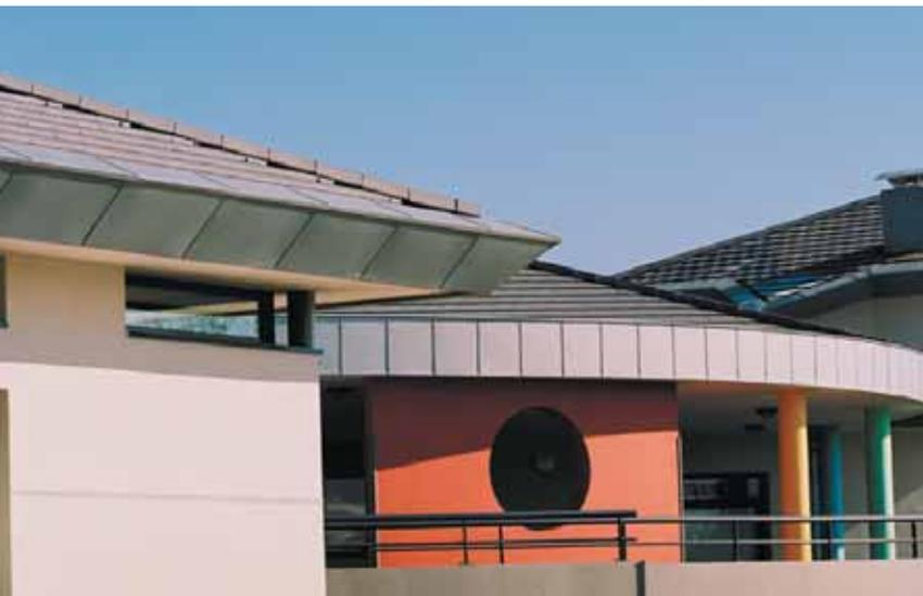
posée à joints croisés et coupée aux arêtes donne de la fluidité à la succession de pans de toiture et au jeu d'arêtes et de noues.
