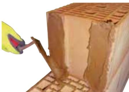
En zone sismique\*, les joints verticaux sont réalisés par encollage des briques au mortier pour joints minces, soit à l'aide du rouleau, soit par graissage à la truelle ou par remplissage de la poche à mortier au mortier bâtard.
