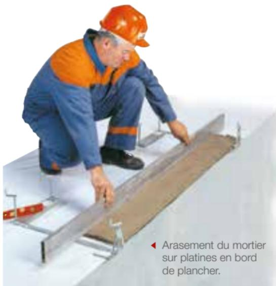
◀ Arasement du mortier sur platines en bord de plancher.
