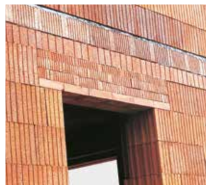
Linteau avec prélinteau et briques de compensation.
