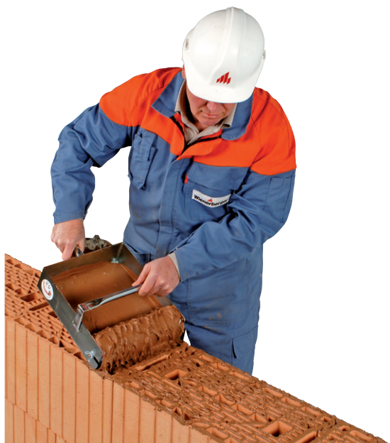
Brique rectifiée pour Maçonnerie Roulée® et DRYFIX®
