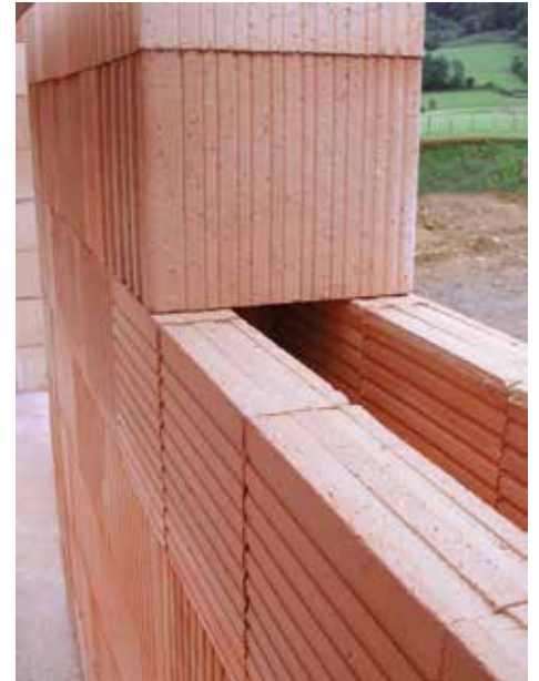
Encadrement d'ouverture sous appui en zone sismique
