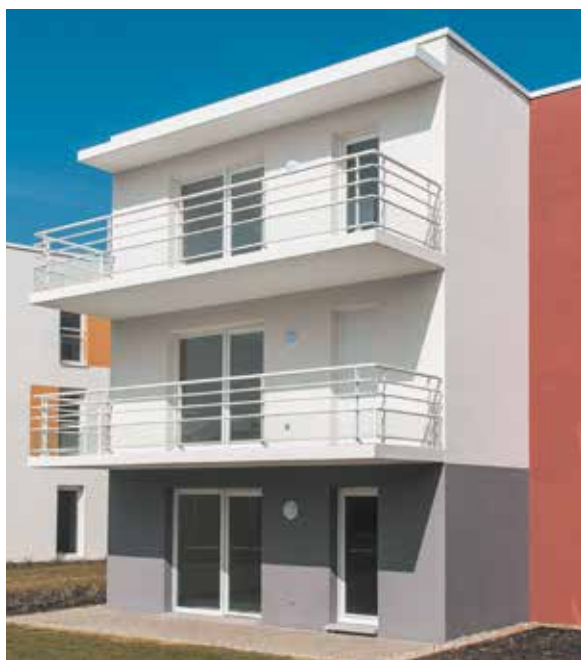
Caserne de gendarmerie , Mulhouse (68) - architectes Malot Architecture, Nancy (54) & Architecture et Synthèse, Sceaux (92) - maître d'ouvrage MINDEF, Strasbourg (67) entreprise mandatée Pertuy Construction, Maxéville (54) - brique Porotherm GF R20
