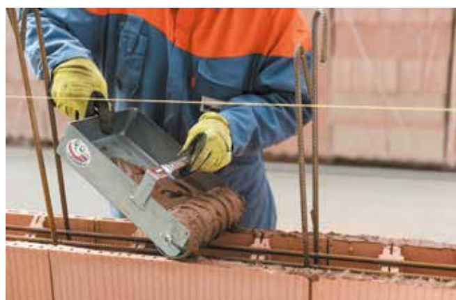
6 Après dépoussiérage et humidification, dépose du mortier joint mince au rouleau
