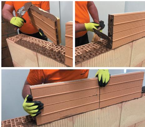
Jointes horizontaux et verticaux sont réalisés au mortier joint épais
