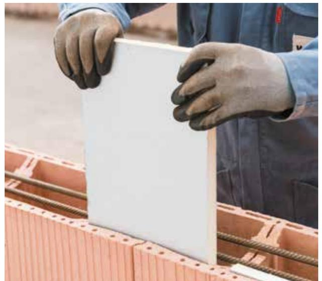
Glissé entre les parois, l'isolant est maintenu par des guides lors du coulage du béton.
