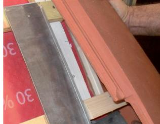
**Rabat droit.** Mettre une cale sous le rabat au nez pour l'ajuster à la hauteur de la tuile d'aération basse. Prolonger l'emboîtement du rabat à la gouttière par un couloir. Rogner le dessous de la baguette d'emboîtement de la tuile d'aération basse pour que celle-ci s'emboîte parfaitement.
