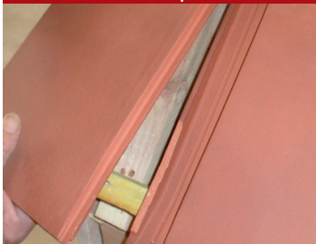
Tuile à bord gauche. Rogner le dessus de la baguette d'emboîtement de la tuile d'aération basse pour que le rabat gauche s'emboîte parfaitement.
