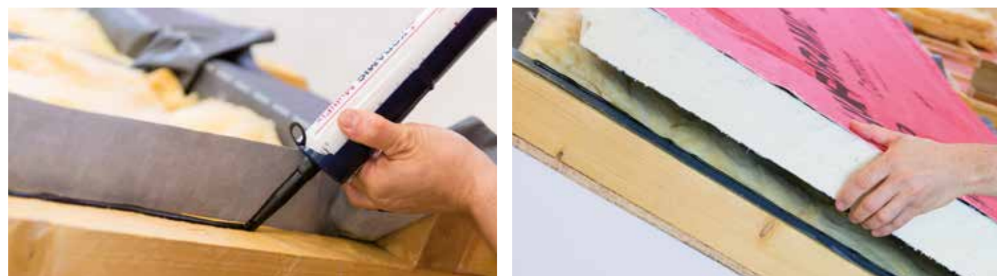
Le pare-vapeur doit impérativement être continu sur les parties verticales, par croisement et collage.
