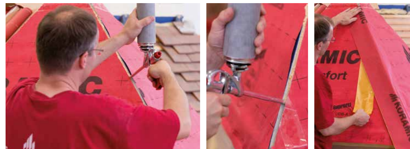
Arêtier Le pare-vapeur doit impérativement être continu sous l'arêtier, par croisement et collage.
