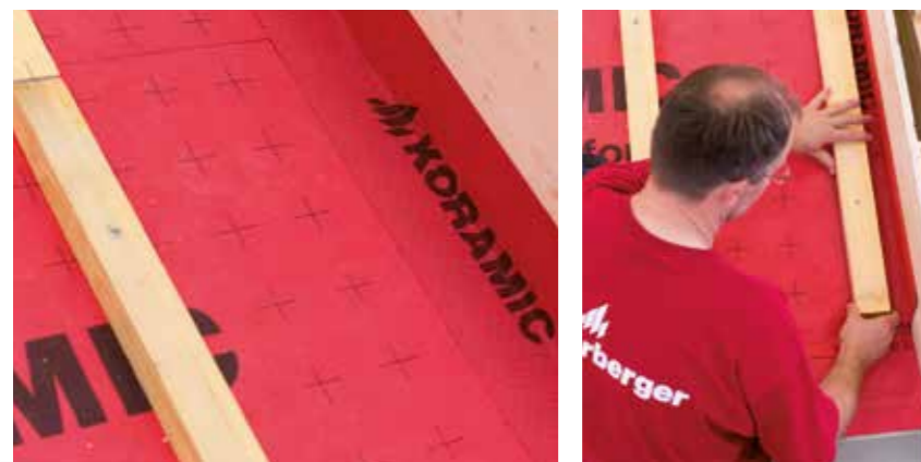
Solin Le pare-vapeur doit impérativement être continu sur les parties verticales, par croisement et collage.
