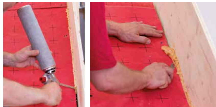
Noue Le pare-vapeur doit impérativement être continu sous la noue, par croisement et collage.
