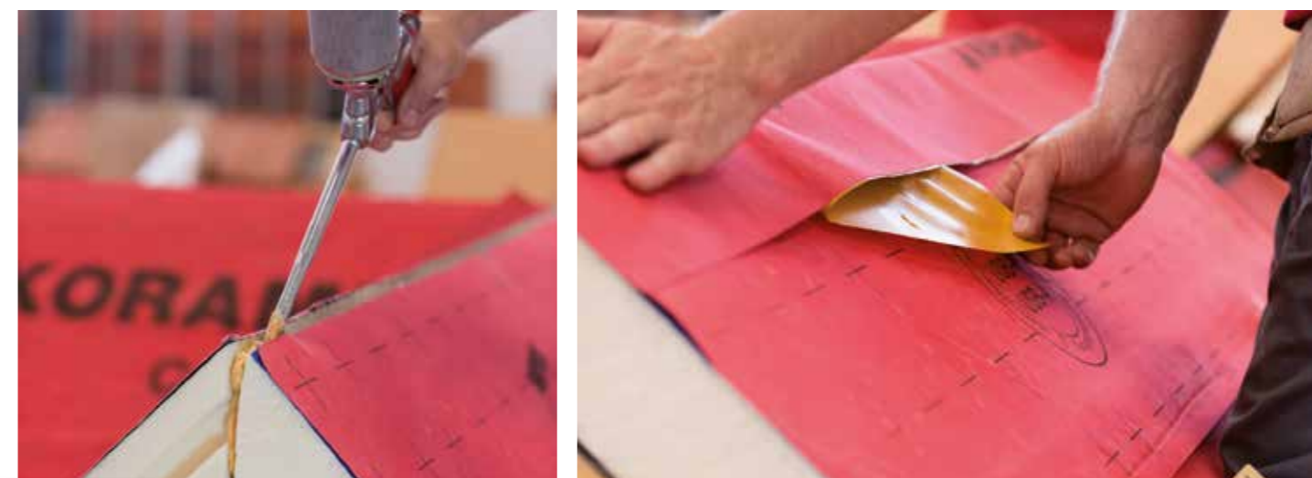
Faîtage Le pare-vapeur doit impérativement être continu sous le faîtage, par croisement et collage.
