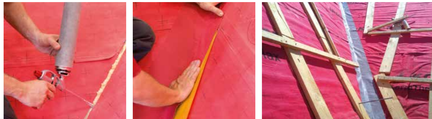
Noue Le pare-vapeur doit impérativement être continu sous la noue, par croisement et collage.
