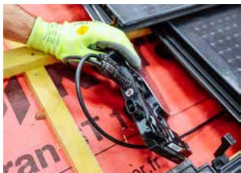
Schéma 1 - Mise en place bouchon fin de ligne
