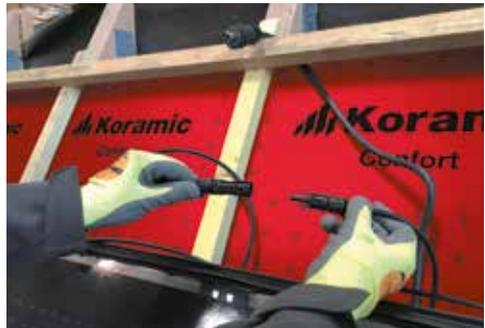
Si il est nécessaire de faire passer les câbles entre les lés de l'écran de sous-toiture, il faut respecter les règles d'étanchéité tels que définis dans le DTU 40.29. Les câbles peuvent ensuite être mis en attente sous la toiture.
