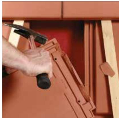
**4** Supprimer si besoin quelques reliefs pour une "repose" plus aisée, sans détruire complètement les emboîtements d'étanchéité.
