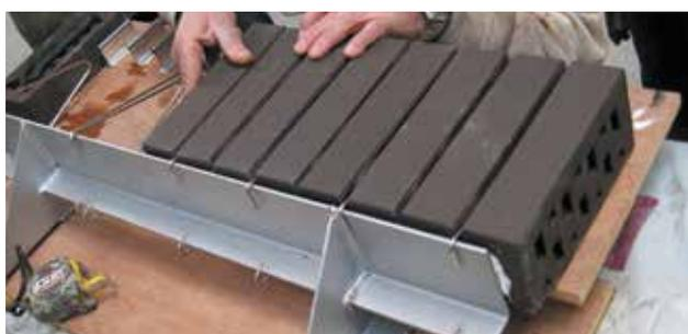
Utilisation d'armatures type Murfor noyées dans les joints
