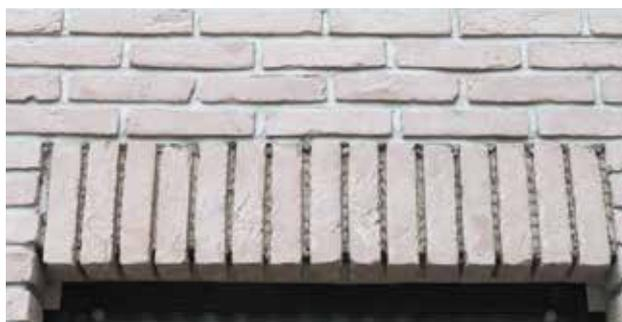
Les briques en linteau sont posées sur des cornières métalliques ou ajustées sur place pour servir de coffrage à un linteau béton armé; autre possibilité : utiliser des linteaux de la gamme prémaçonnée Terca (nous consulter).
