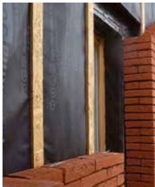
Les attaches seront fixées dans les montants verticaux de l'ossature bois en respectant le nombre au m<sup>2</sup> préconisé par le DTU 20.1. La réglementation concernant les dispositions constructives en pied de mur, l'épaisseur de la lame d'air et sa ventilation, la mise en œuvre du pare-pluie et la hauteur maximum
