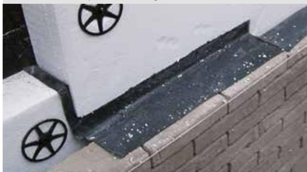
Pour permettre l'évacuation des eaux collectées par la membrane d'étanchéité, il faut prévoir tous les 3 briques environ un joint vertical non garni (maximum 1 ml) de la première assise au-dessus de cette membrane; ce joint dégarni doit être en parfaite communication avec la lame d'air et l'on doit veiller, lors du montage, à maintenir cette lame d'air propre. Les matériaux utilisés pour le dispositif de recueil d'eau sont choisis parmi la liste du DTU 20.1 P1-2 article 5.5.
