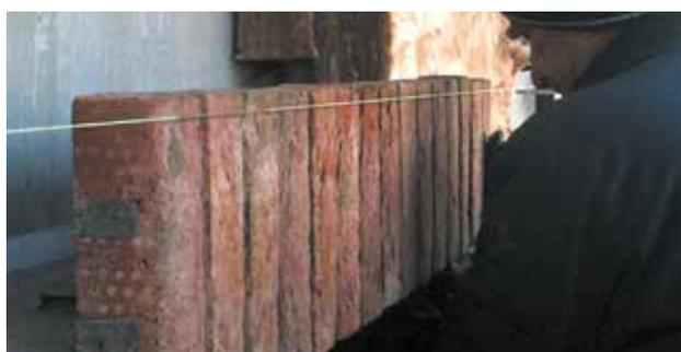
Linteau de gamme Prémaçonnés servant de fond de coffrage au linteau béton armé
