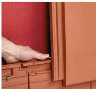
**4** L'emboîtement de la tuile est "crocheté" par l'extrémité du crochet de pannetonnage.
