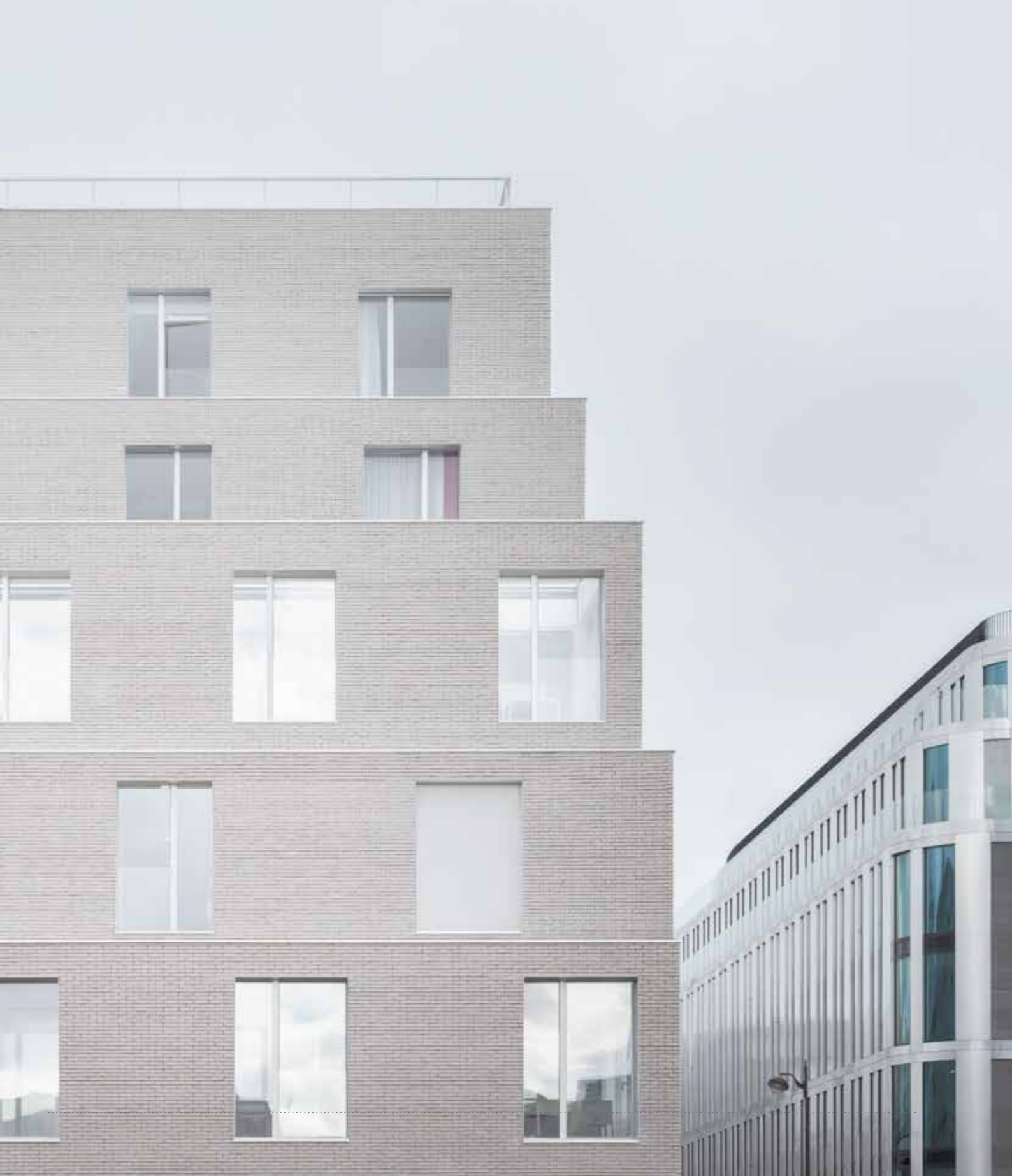
Hébergements et centre d'accueil à Paris (75) - Architecte Lambart Lenack - Maître d'ouvrage Paris Habitat - Photographe : Simone Bossi - Collection Agora gris agate
