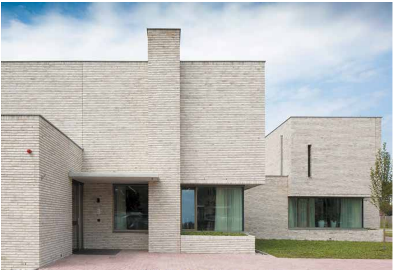
En haut : Maison individuelle à Uden (Pays-Bas) Collection Darwin Falls multi
