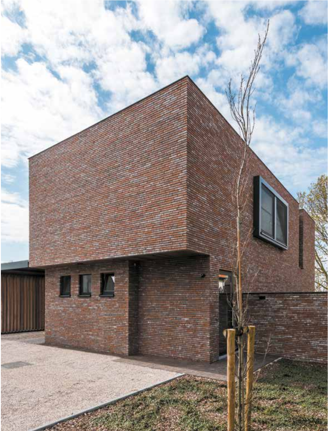
Maison individuelle à Dentergem (Belgique) - Collection Metropolis brun urbis
