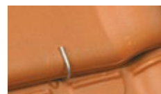
F support de latte faîtière ajustable
