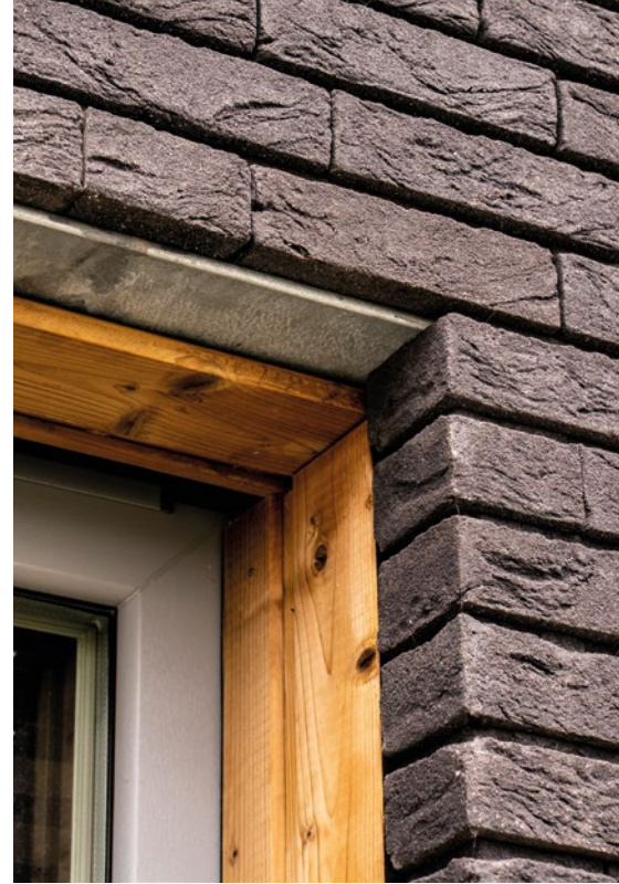
Le joint de retrait sur la brique de parement crée un aspect brique traditionnel, mais la brique est posée sans mortier.
