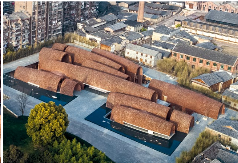
Les huit voûtes en forme de cigares rappellent la forme traditionnelle des fours à porcelaine et varient en hauteur, largeur et courbure.
