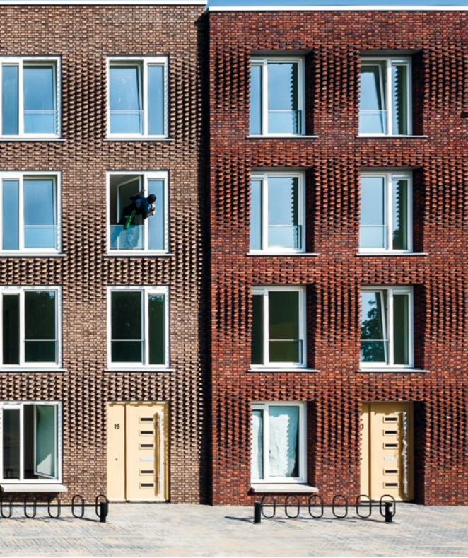
Cinq types de briques apparentes, des façades décalées et l'appareillage en ondulation créent une dynamique originale.
