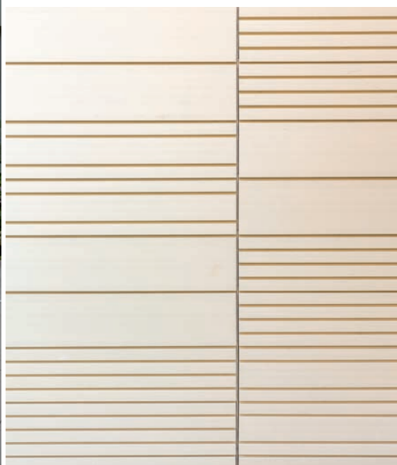
Détails de façade
