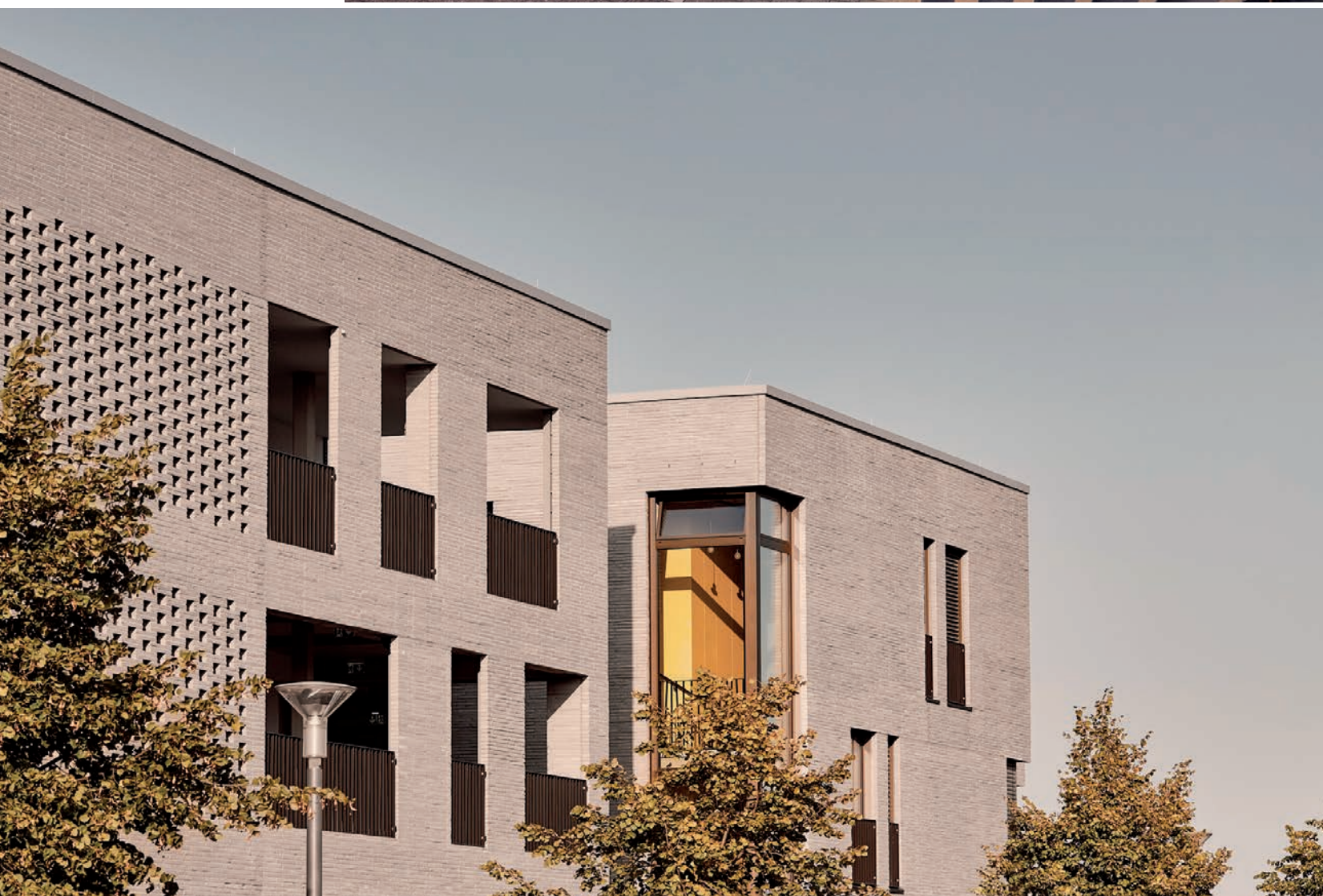
Les murs extérieurs du bâtiment sont recouverts de briques Polaris réfractaires humides Wienerberger de 510 mm.
