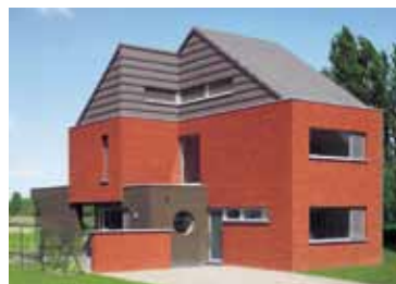
Toiture et bardage en Actua Ardoisé
