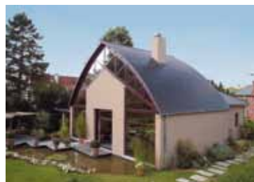
Rénovation et création d'une toiture courbée en tuile Plate 301 gris ardoisé émaillé mat
