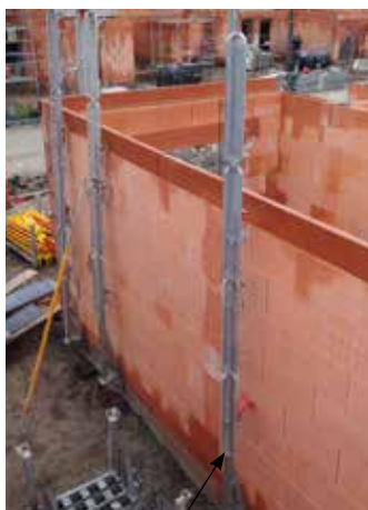
Mise en place des mâts extérieurs
