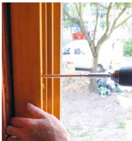
Exemples de fixation au travers du profilé
