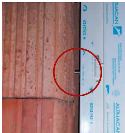
Exemples de fixation au travers du profilé
