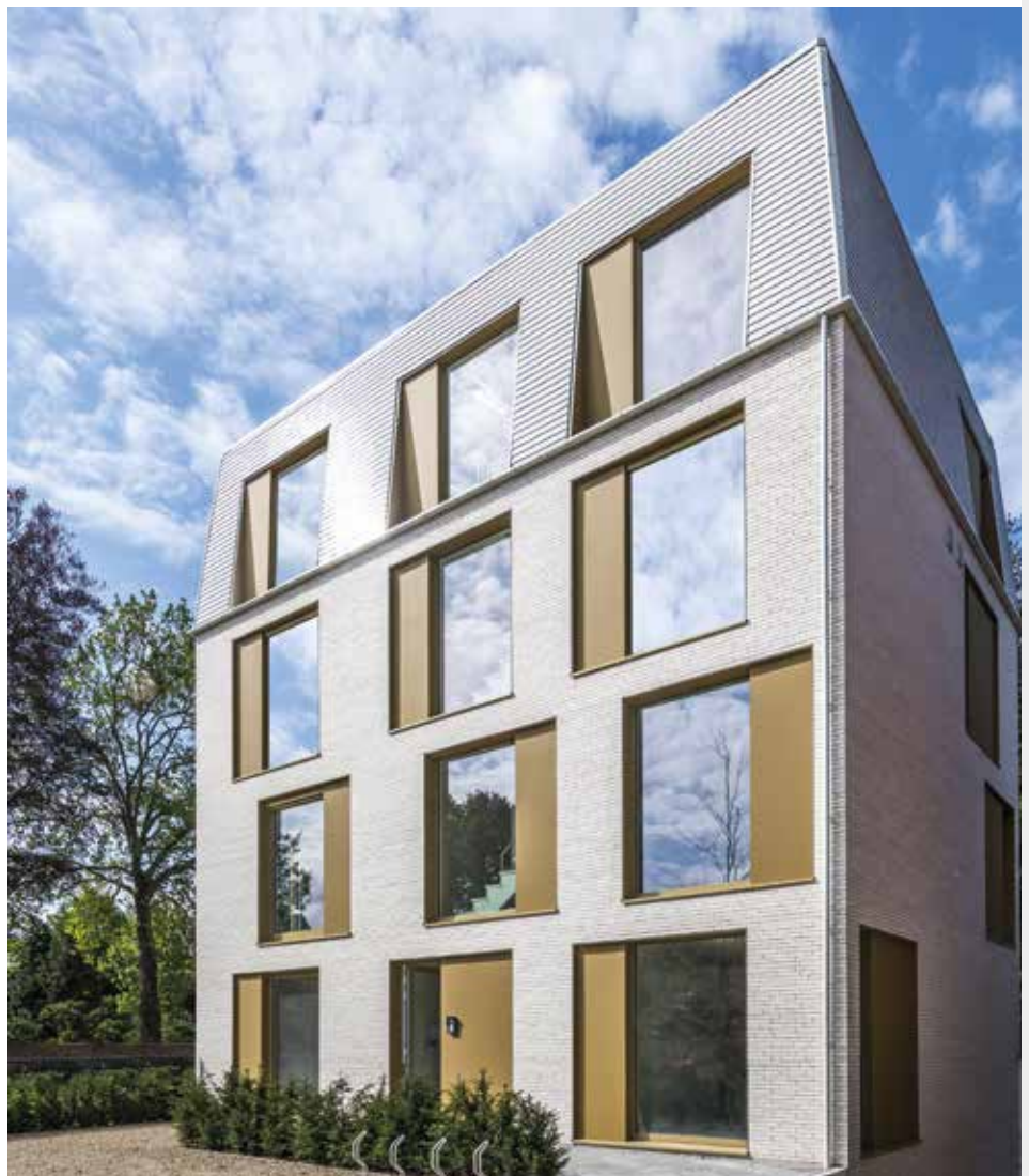
Logements du domaine Hooghuys, Ekeren (Belgique) Architectes Binst Architects et Architectenassociatie Angst & D'hoore, Antwerpen Collection Eignia blanc arctica
