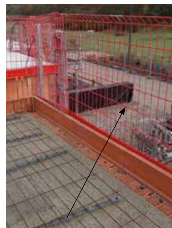
Protection grillagée en place
