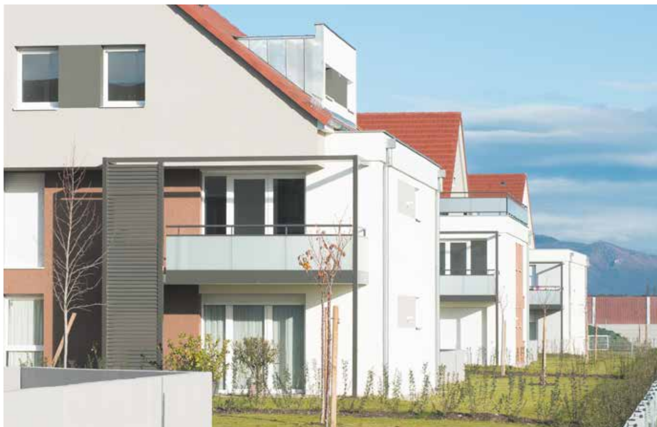
Domaine des Cépages, Colmar (68) - architecte AEA architecte, Thiemenn Rodrigue - maître d'ouvrage SCI La Hardt, Alsace Promotion - photographe Grégory Tachet - brique Porothersm R25 Th+
