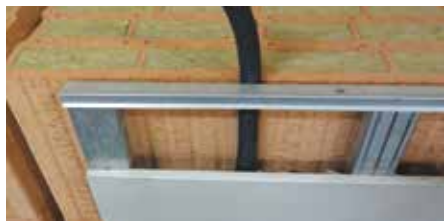
Finition plaque de plâtre sur ossature
