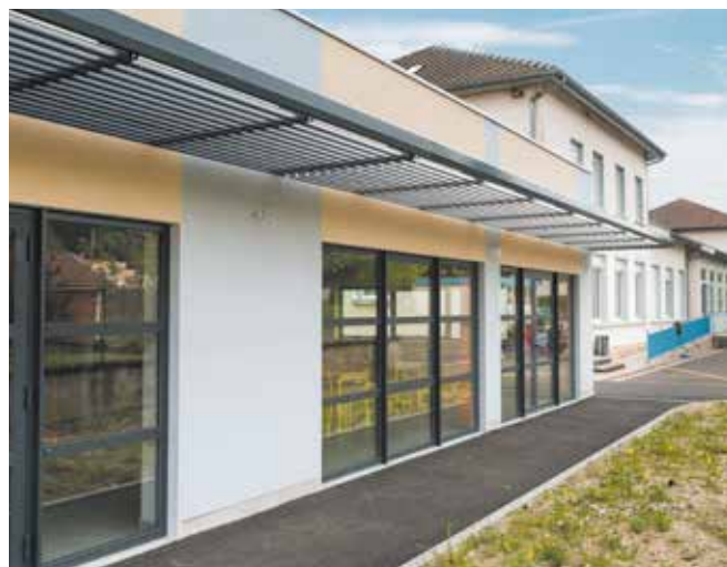
garderie, Velaines (55) - architecte Dominique Millet (55) photographe Grégory Tachet - brique Climamur® 36
