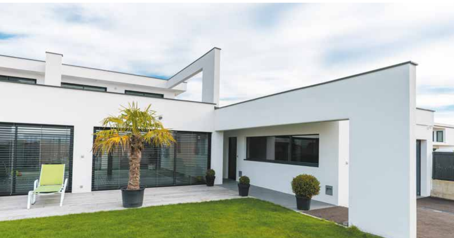
maison individuelle, Truchtersheim (67) - brique Porotherm GF R20
