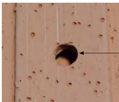
Trou parfaitement cylindrique, sans éclatement avec mèche ou foret spécial brique
