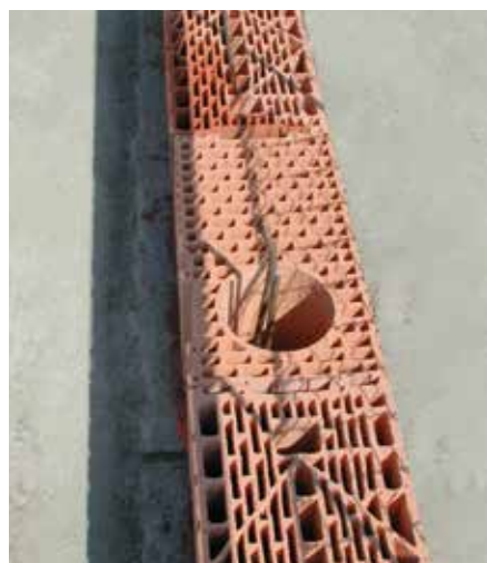
Chaînage vertical en partie courante
