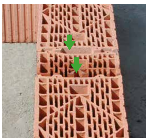
Jointes verticaux à remplir.
