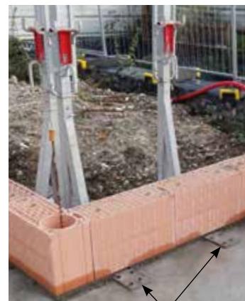
Platines fixées sur dalle de rez-de-chaussée
