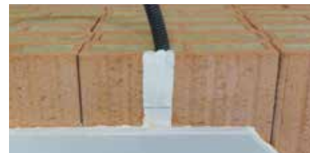
Finition enduit plâtre ou mortier
