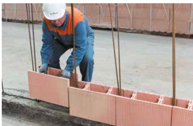
5 Mise en place du 1 er rang
