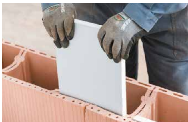
7 Mise en place de l'isolant de 20 mm entre cloisons
