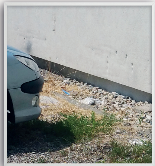
Impacts de pare-chocs sur une ITE
