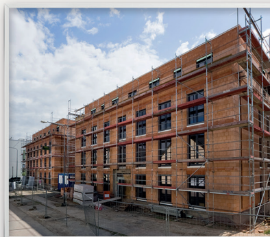
Logements collectifs R+3 en Climamur 42
