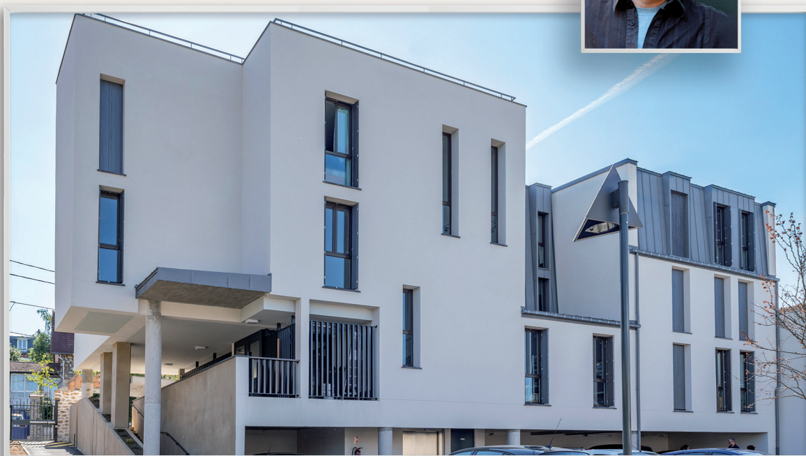
Ensemble de 25 logements sociaux Villemoisson-sur-Orge (91) en Climamur 36
