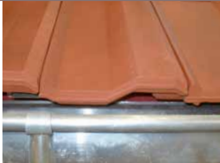
Tuile d'aération basse. Les renforts réhaussent le produit pour assurer la ventilation : 72 cm 2 au ml.
