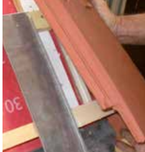
Tuile à bord droit. Mettre une cale sous le rabat au nez pour l'ajuster à la hauteur de la tuile d'aération basse. Prolonger l'emboîtement du rabat à la gouttière par un couloir. Rogner le dessous de la baguette d'emboîtement de la tuile d'aération basse pour que celle-ci s'emboîte parfaitement.
