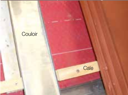
Mettre une cale sous la 3/4 de tuile pour l'ajuster à la hauteur de la tuile d'aération basse. Prolonger son emboîtement à la gouttière par un petit couloir.
