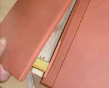
Tuile à bord gauche. Rogner le dessus de la baguette d'emboîtement de la tuile d'aération basse pour que le rabat gauche s'emboîte parfaitement.
