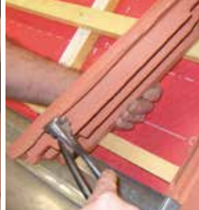
Tuile à bord droit. Mettre une cale sous le rabat au nez pour l'ajuster à la hauteur de la tuile d'aération basse. Prolonger l'emboîtement du rabat à la gouttière par un couloir. Rogner le dessous de la baguette d'emboîtement de la tuile d'aération basse pour que celle-ci s'emboîte parfaitement.
