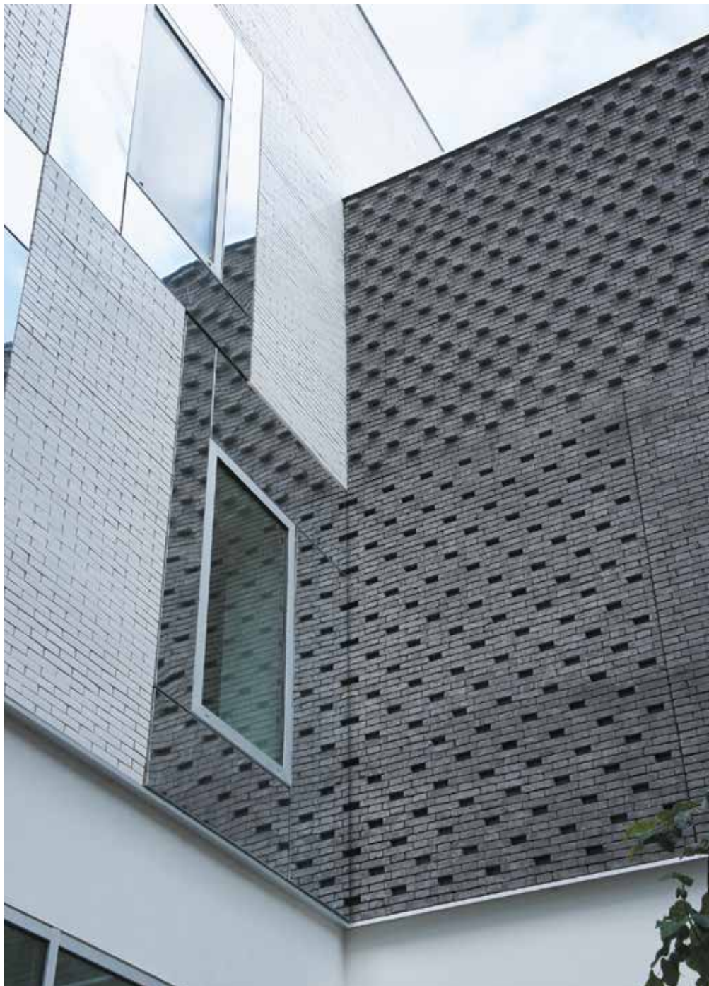
IUT Paris 8, Montreuil (93) - architecte 2/3/4 Architecte - briques Agora gris titane et gris argenté
