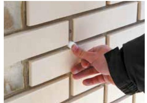
**3** Insertion de la cheville et vissage. Mise en place des bouchons polystyrènes.
