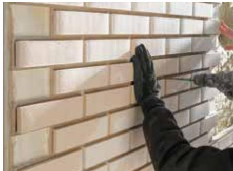
**2** Pose des panneaux Kess. Perçage à travers les panneaux Kess jusqu'au mur support.
