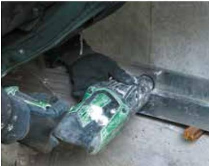
**1** Pose du rail de départ par fixation mécanique. Pose d'un cordon de mousse polyuréthane.
