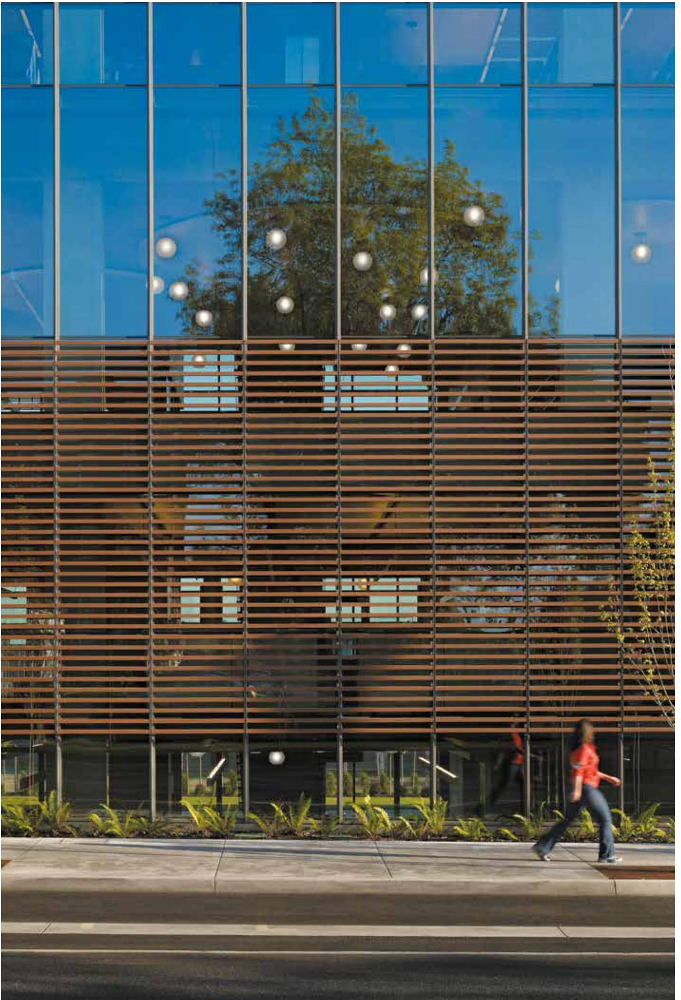
Bibliothèque régionale de Fort Vancouver (USA) - Architecte : The Miller Hull Partnership - Bardage Barro® brise-soleil
