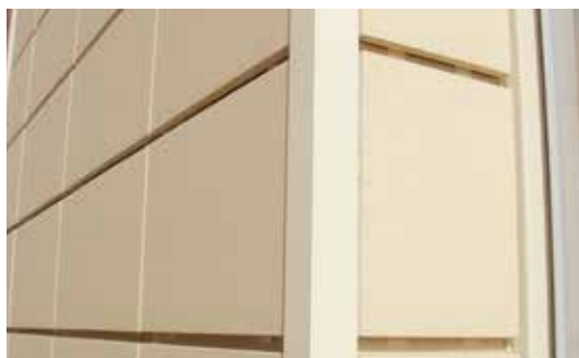
Détail angle sortant avec profilé carré
