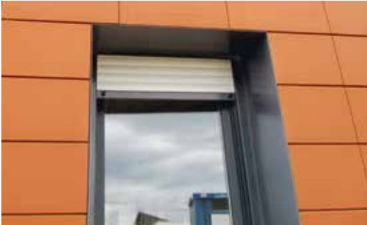
Détail linteau de fenêtre en tôle
