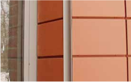
Détail angle sortant avec profilé ouvert
