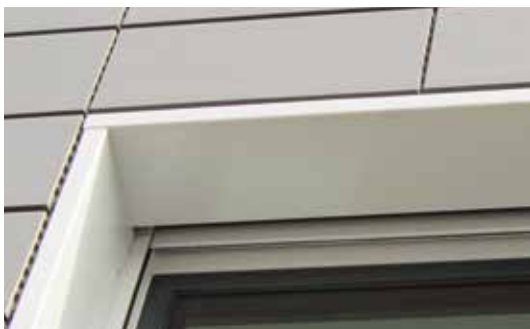
Détail linteau de fenêtre en tôle
