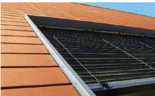
Détail linteau de fenêtre en tôle avec B50
