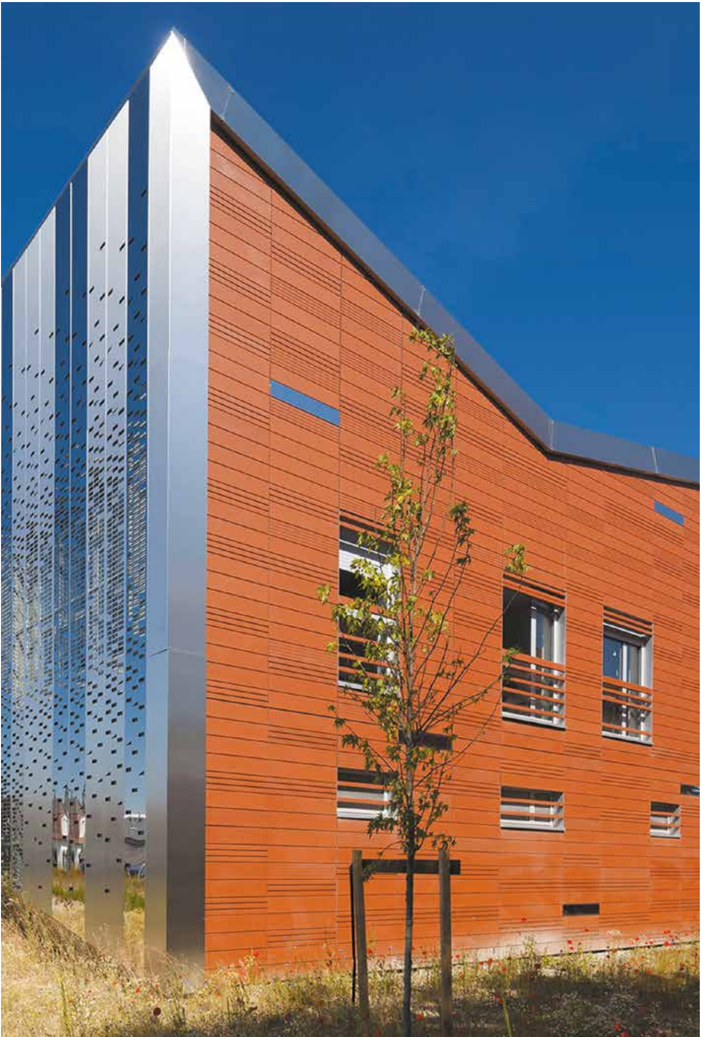
Caserne Baudimont à Arras (62) - Bardages Argeton® Tampa, Linéa et Terzo rouge Toscane
