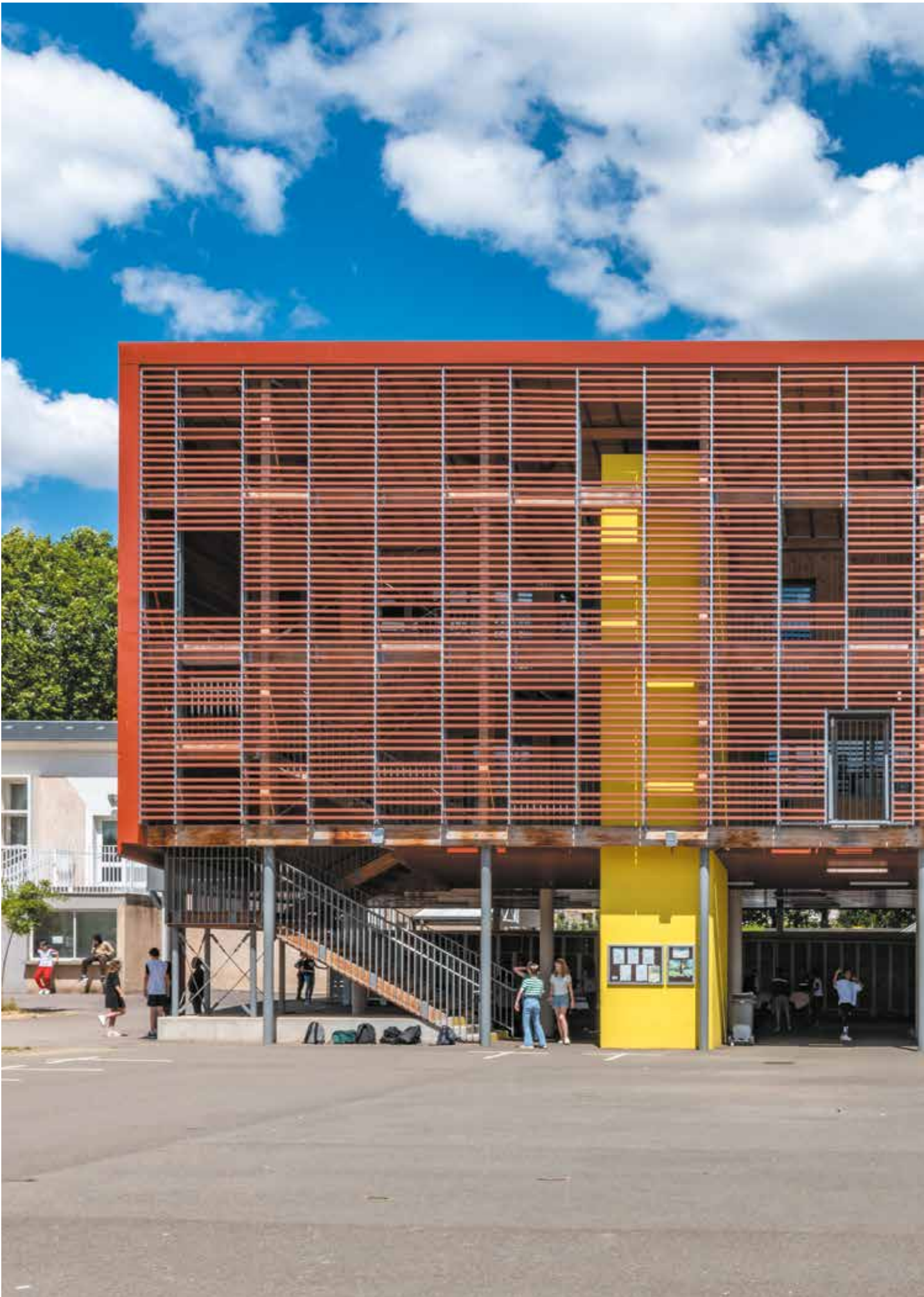
Collège Albert Camus à Dreux (28) - Architecte : SCOP d'architecture B-A-Bo + Agence RVL à Tours - Bardage Barro® rouge
