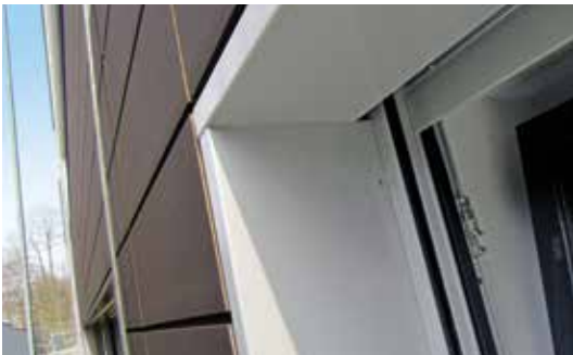
Détail ébrasement métallique
