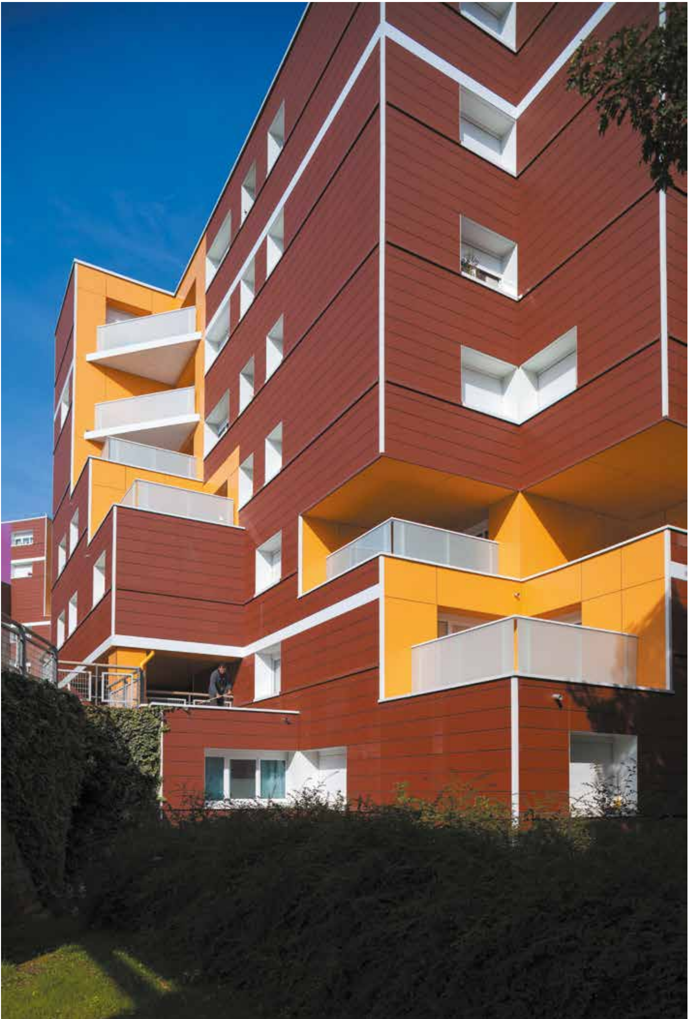
Logement collectif "Des Vergers" à Villeneuve d'Ascq (59) - Bardage Argelite® rouge brun
