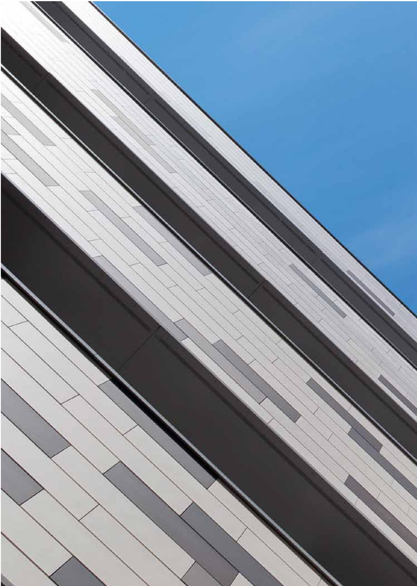
Immeuble "Le Plaza" à Lille (59) - Bardages Argelite® et Argeton® blanc carrare, gris basalte, gris métal
