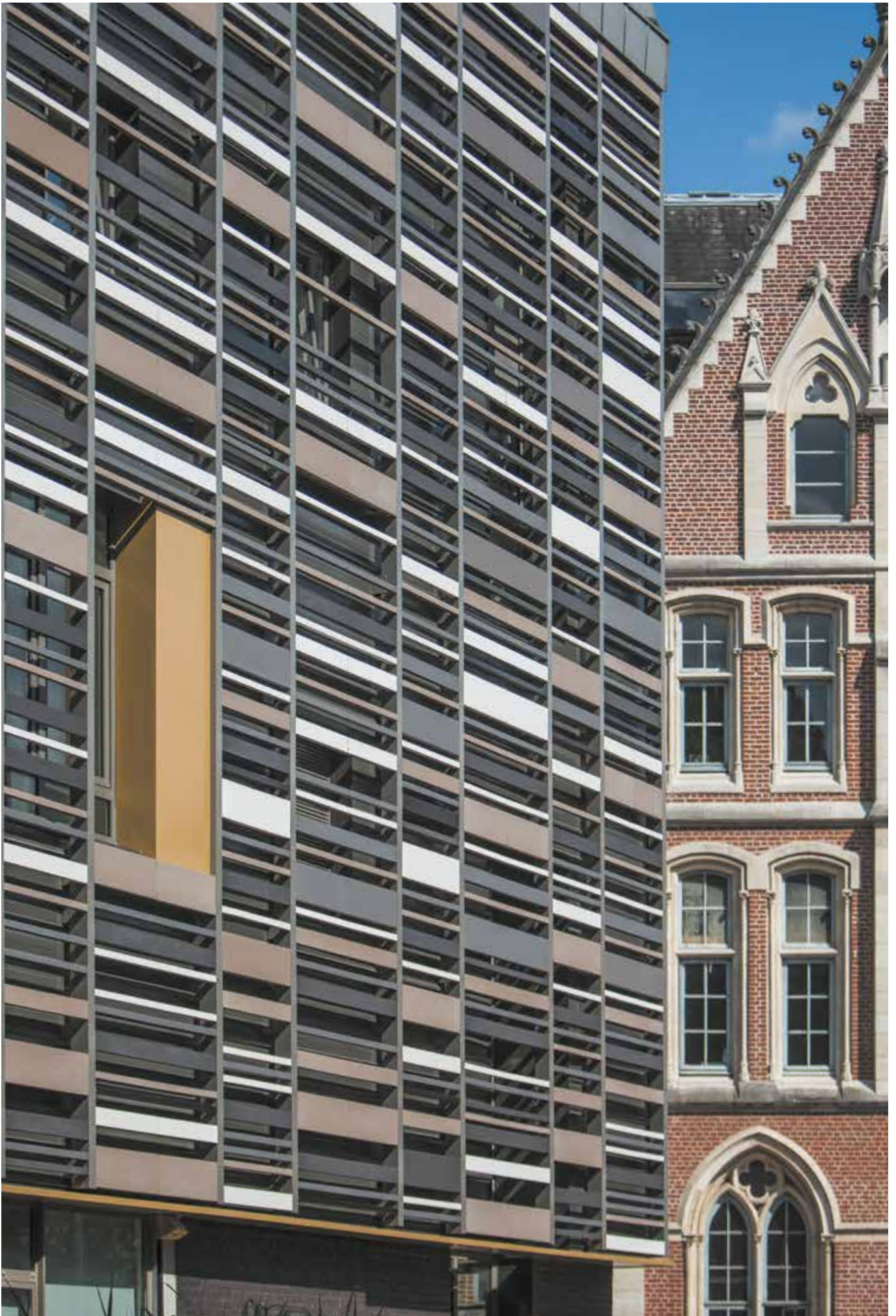
Facultés de l'Université Catholique "Le Rizomm" à Lille (59) - Bardage Barro® brise-soleil, 6 teintes et 4 formats de modules
