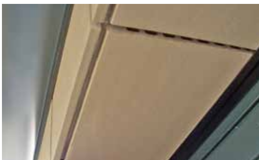
Détail linteau fenêtre en bardeaux
