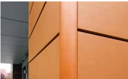
Détail angle sortant avec profilé quart-de-rond
