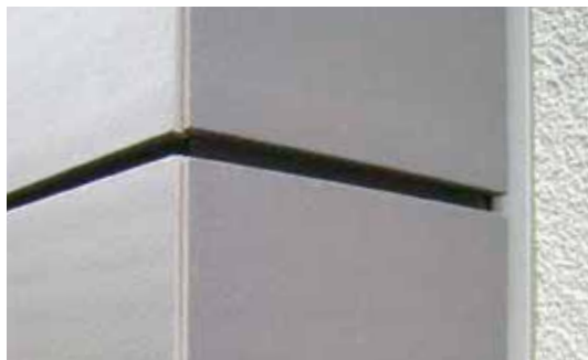
Détail angle sortant coupe à l'onglet
