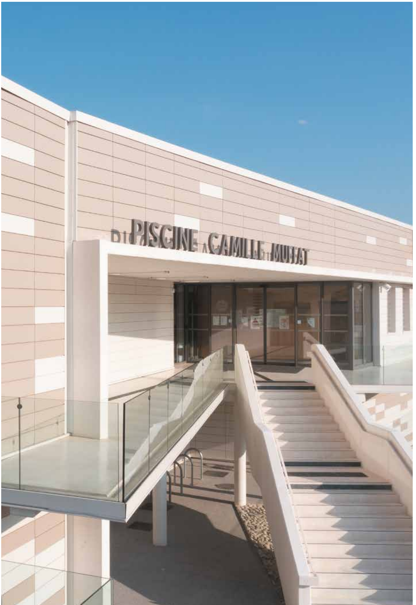
Piscine municipale à Portes-lès-Valence (26) - Bardages Argeton® blanc carrare et Argelite® gris argent
