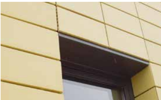
Détail ébrasement en terre cuite
