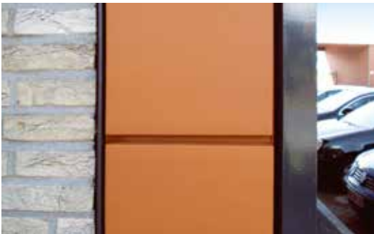
Détail angle sortant avec profilé fermé
