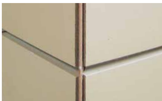
Détail angle sortant avec profilé "en Y"
