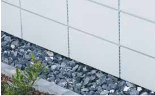
Détail inférieur profilé perforé anti-rongeur
