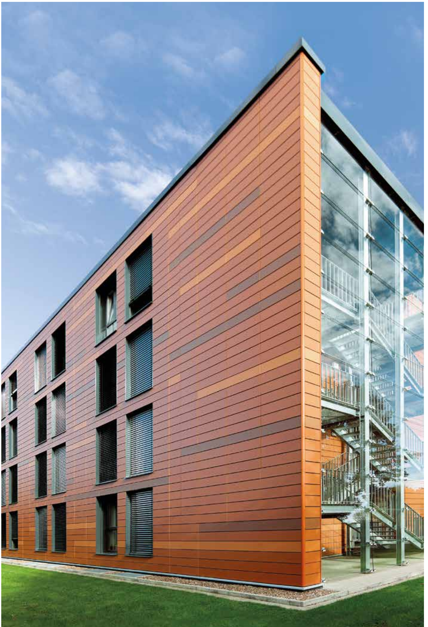
Résidence étudiante à Minden (Allemagne) - Bardage Argeton® Tampa rouge saumon, rouge naturel et rouge brun
